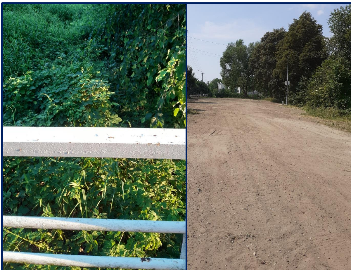
Ryc. 16 Zarośnięty kanał po zachodniej stronie wyspy (po lewej) i niezagospodarowany teren przy ulicy Wieluńskiej (po prawej)
