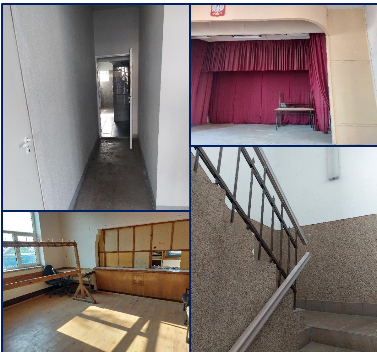
Ryc. 22 Wnętrze budynku Ochotniczej Straży Pożarnej w Osjakowie (podobszar Osjaków p1n-zach) Źródło: materiały z wizji lokalnej przeprowadzonej w dniach 19-20.06.2023 r.
