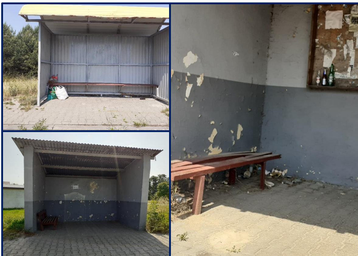
Ryc. 24 Przystanki autobusowe przy drodze krajowej nr 74 (obszar rewitalizacji)
